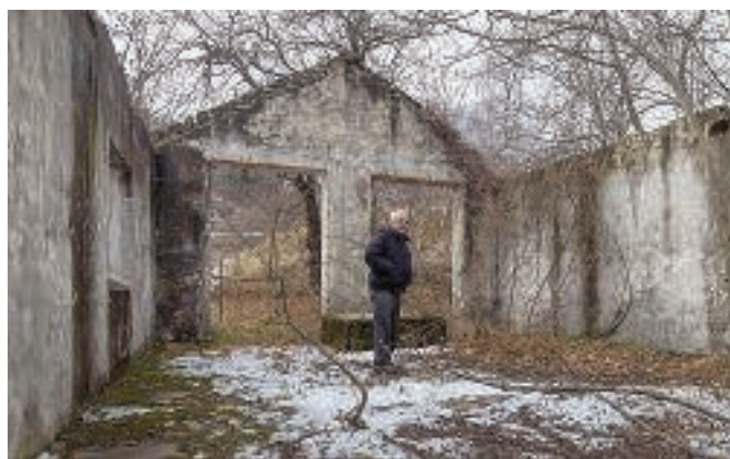
La stazione delle teleferiche che venne costruita negli Anni '30
